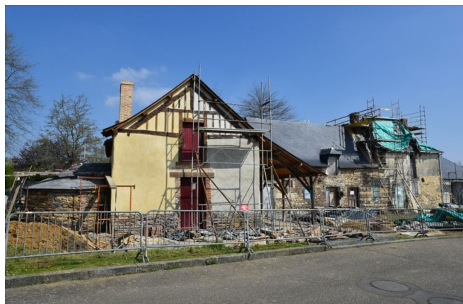
Photo de la Ferme de la Marionnais en cours de travaux
