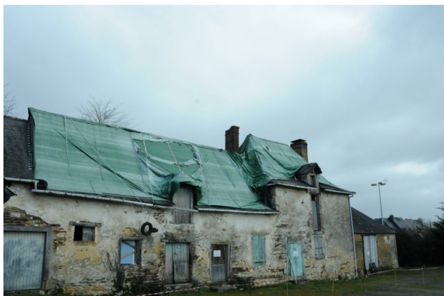
Photo de la Ferme de la Marionnais avant le démarrage des travaux
