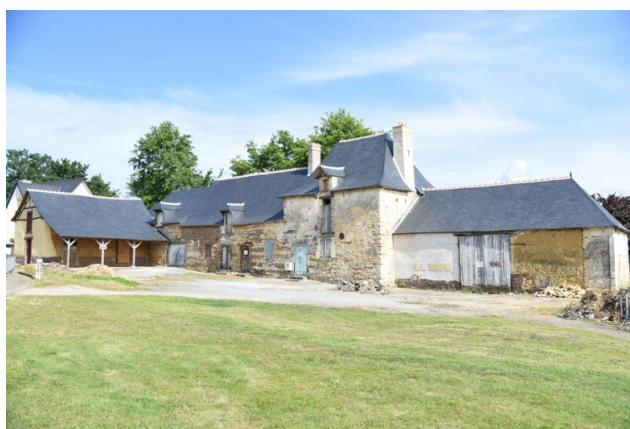
Photo de la Ferme de la Marionnais après plus de 2 années de travaux
